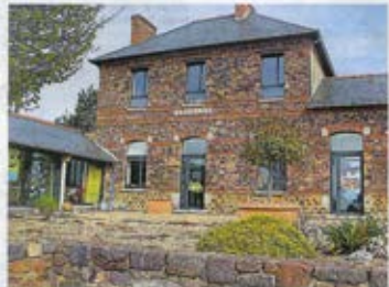
À Plumelec, la rénovation de l'école maternelle porte la signature de Tiez Breiz
